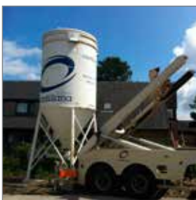
Plaatsing van de silo
