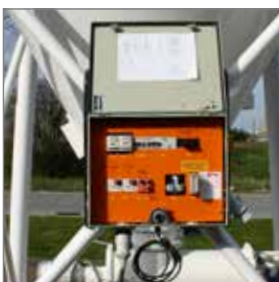
Aansluiting van de elektriciteit
