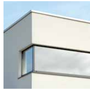
Finition autour d'une fenêtre
