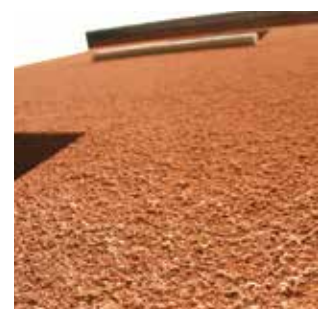
Détail de la structure
