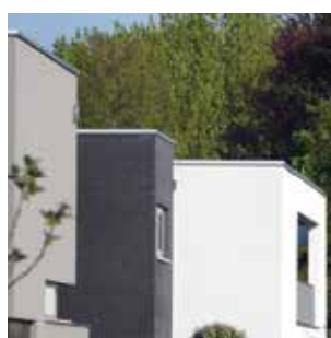
Aspect homogène de l'enduit
