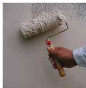
Remise à neuf d'une façade
