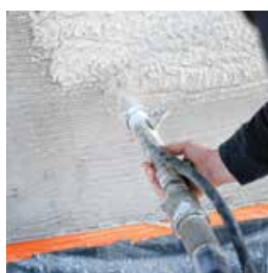
Projection du mortier
