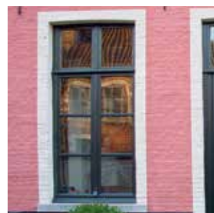
Finition autour d'une fenêtre
