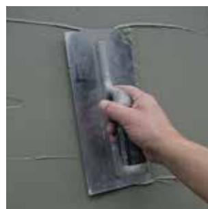
Application de l'enduit
