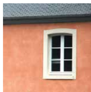
Finition autour d'une fenêtre
