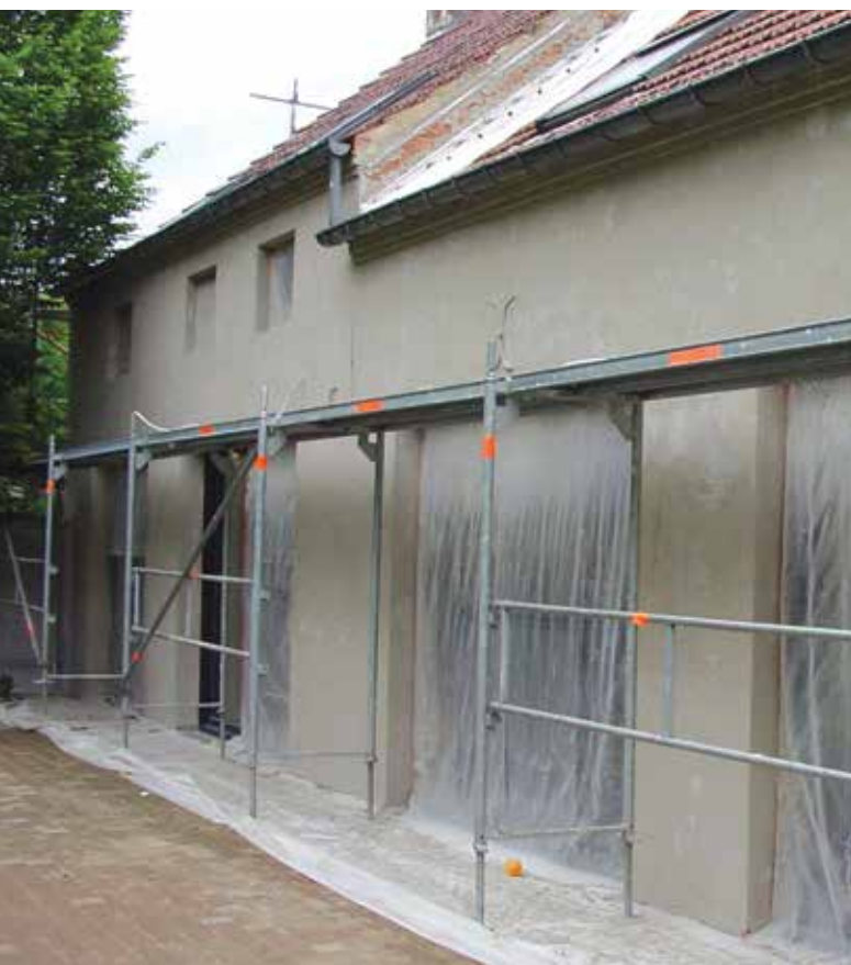
Application de l'enduit
