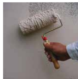
Vernieuwen van een gevel
