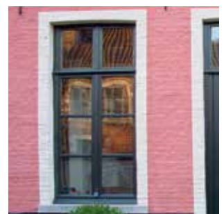
Afwerking rond een venster
