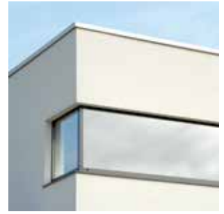
Afwerking rond een venster pleister
