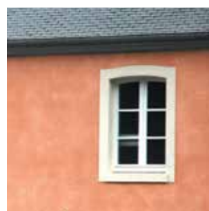
Afwerking rond een venster
