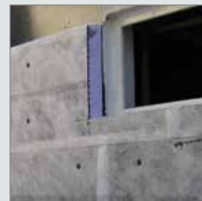
Ce produit novateur pour isolation et drainage est composé de mousse de polystyrène extrudé (XPS) et d'une nappe de drainage revêtue d'un géotextile.
