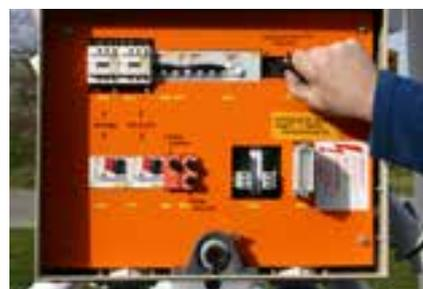
**6** Si nécessaire changer le sens de rotation pour l'inverseur. (voir le bouton 1-0-2 dans l'armoire électrique)
